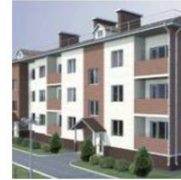
31-квартирный, 3-х этажный жилой дом
